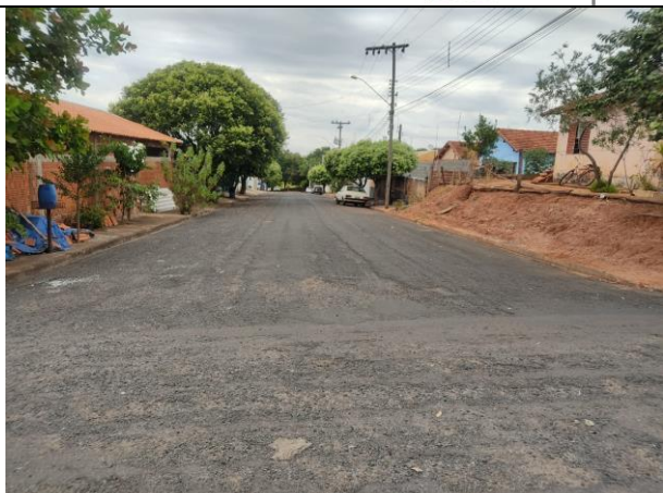
Foto 05: Rua Rosalvo Antônio de Oliveira, esquina com Rua José Jorge ( Trecho 3 )
