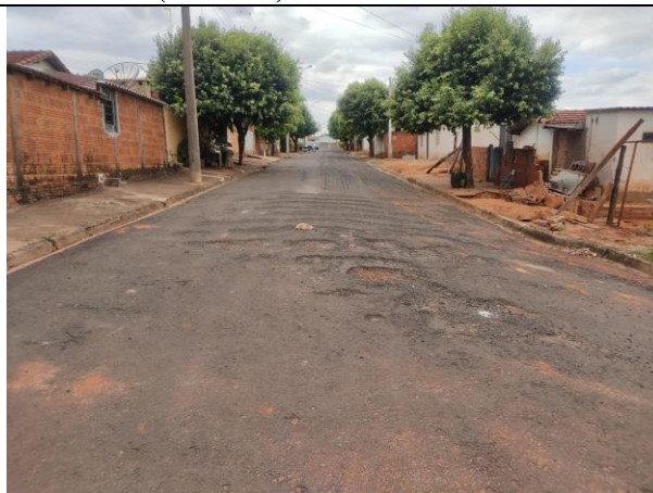
Foto 08: Rua Luiz de Oliveira Jordão, esquina com Rua Antônio Carreira ( Trecho 4 )
